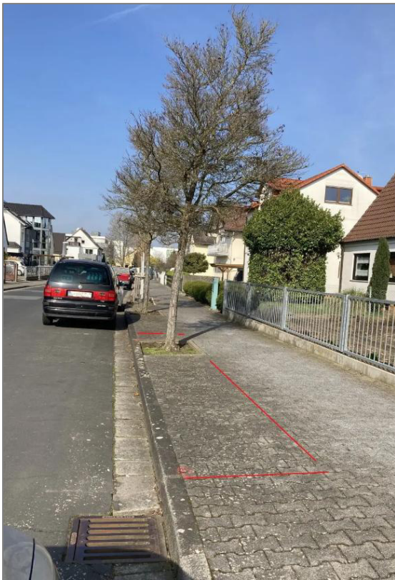
Abbildung 8: Baumgruben im Gehwegbereich vor der Maßnahme (Quelle: DLB Dreieich und Neu-Isenburg AöR 2026)
