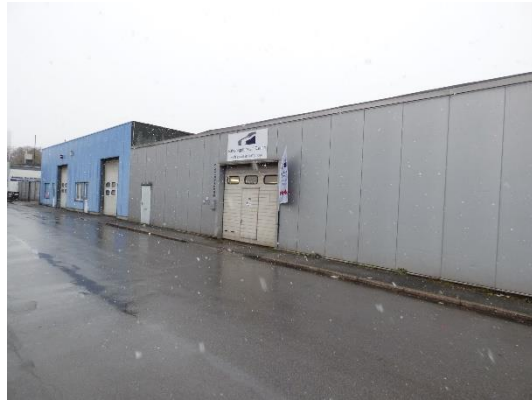
Abb. 32 Südansicht von Gebäude 2.
