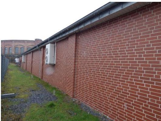
Abb. 24 Südansicht von Gebäude 1.
