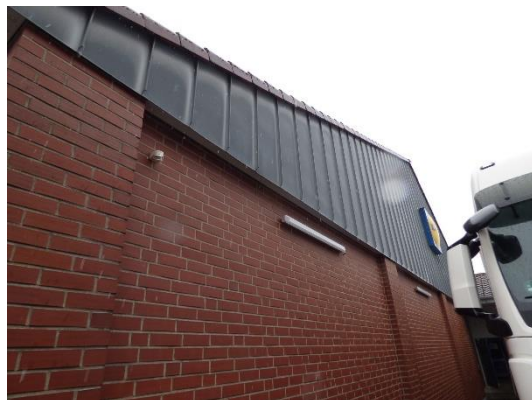
Abb. 25 Westansicht von Gebäude 1.
