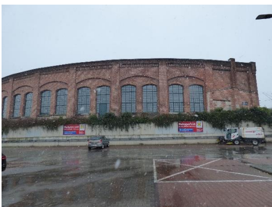
Abb. 9 Lokschuppen westlich des Plangebietes.
