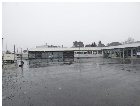
Abb. 15 Parkplatz im Südosten des Plangebietes.
