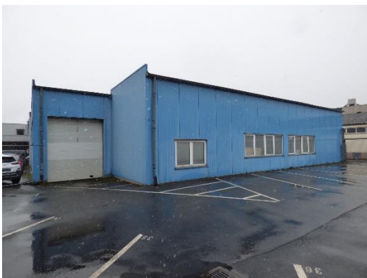
Abb. 29 Westansicht von Gebäude 2.
