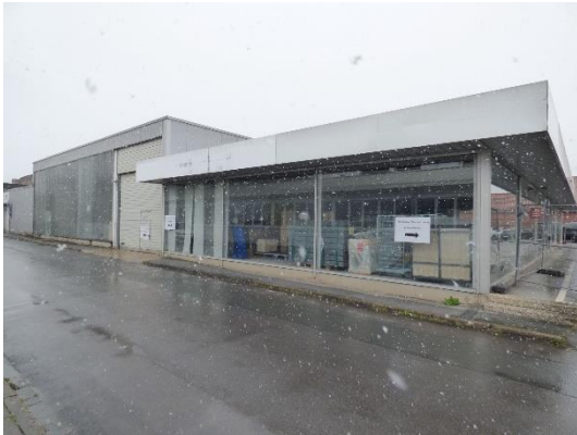
Abb. 31 Südansicht von Gebäude 2.
