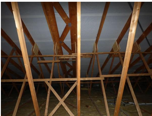
Abb. 18 Dachboden von Gebäude 1.
