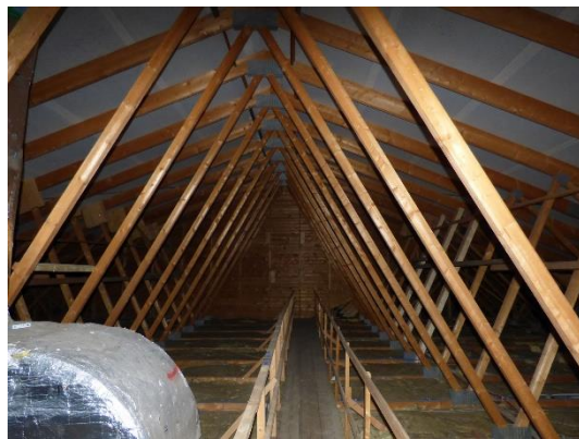
Abb. 19 Dachboden von Gebäude 1.
