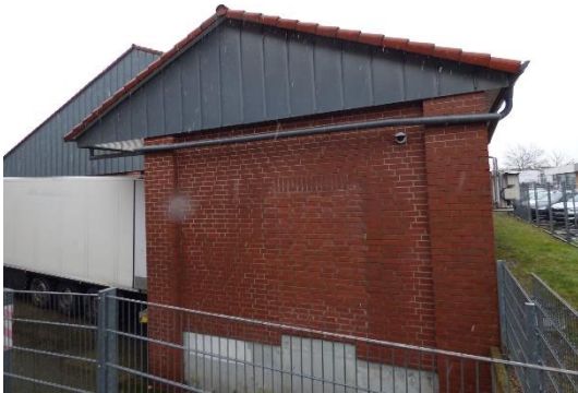
Abb. 26 Westansicht von Gebäude 1.
