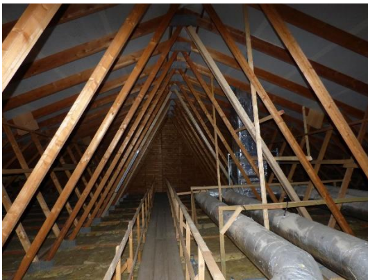
Abb. 16 Dachboden von Gebäude 1.
