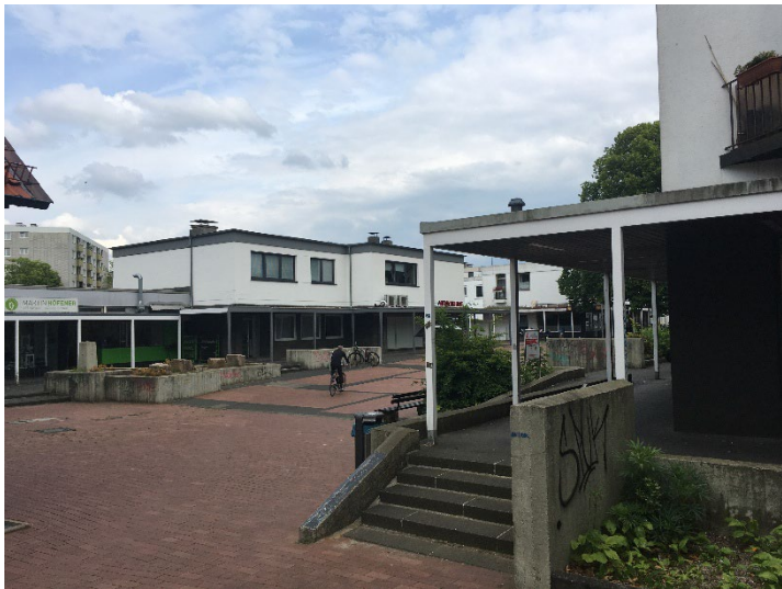
Zugang Ärztehaus vorher (2022)
