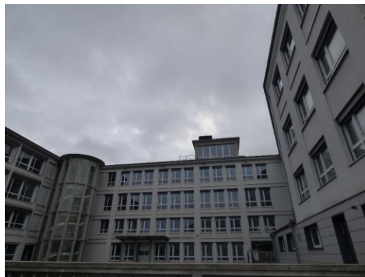
Abb. 5 Leerstehendes Betriebsgebäude im Norden des Plangebietes.
