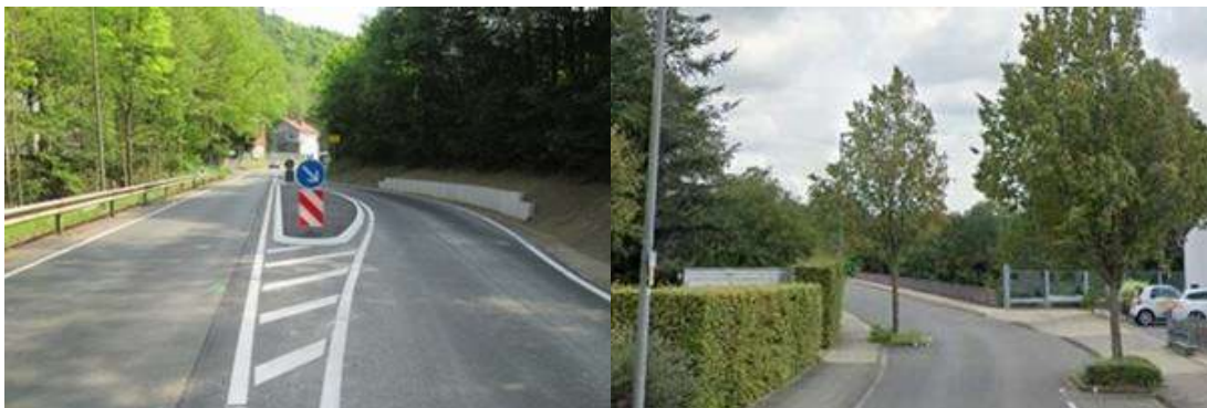
Abbildung 66: Fahrbahnversatz im Ortseingangsbereich (links) | Baumbeste zur Verkehrsberuhigung (rechts)
