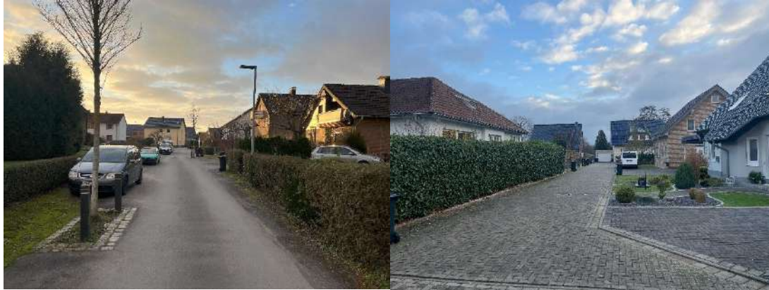
Abbildung 82: Gestaltung Straßenraum Hagenkamp (links) | Fehlende Gehwege Am Lothenkamp (rechts)
