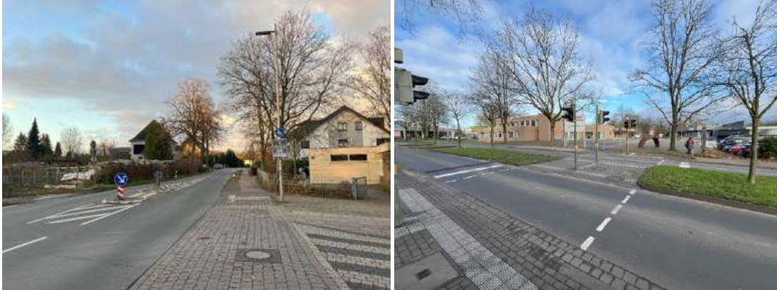
Abbildung 17: bestehende Mittelinsel Am Wellbach (links) | Fußgängerbedarfsampel am Rabenhof (rechts)
