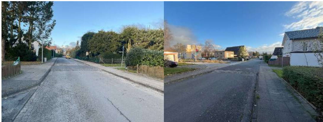
Abbildung 88: Aufpflasterungen im Jungbrunnenweg im Querungsbereich des gemeinsamen Geh- und Radwegs
