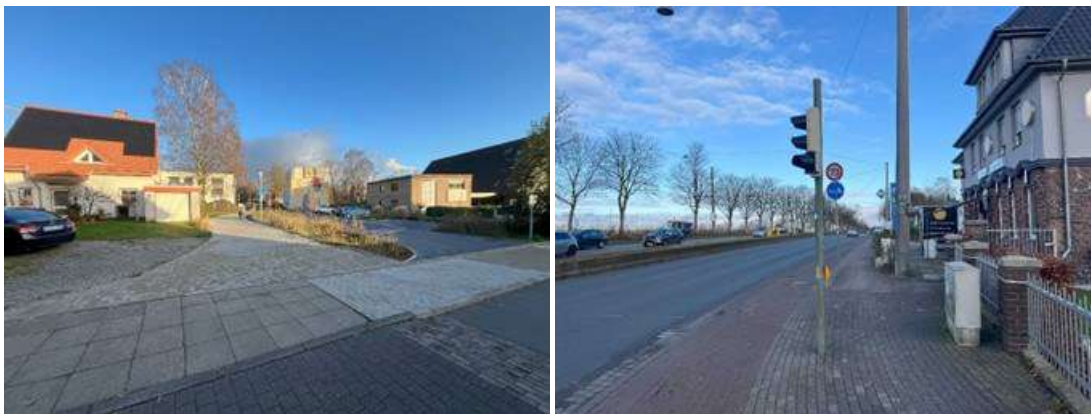
Abbildung 20: eigenständiger gem. Geh- und Radweg mit Aufpflasterung im Jungbrunnenweg (links) | getr. Geh- und Radweg Herforder Straße (rechts)
