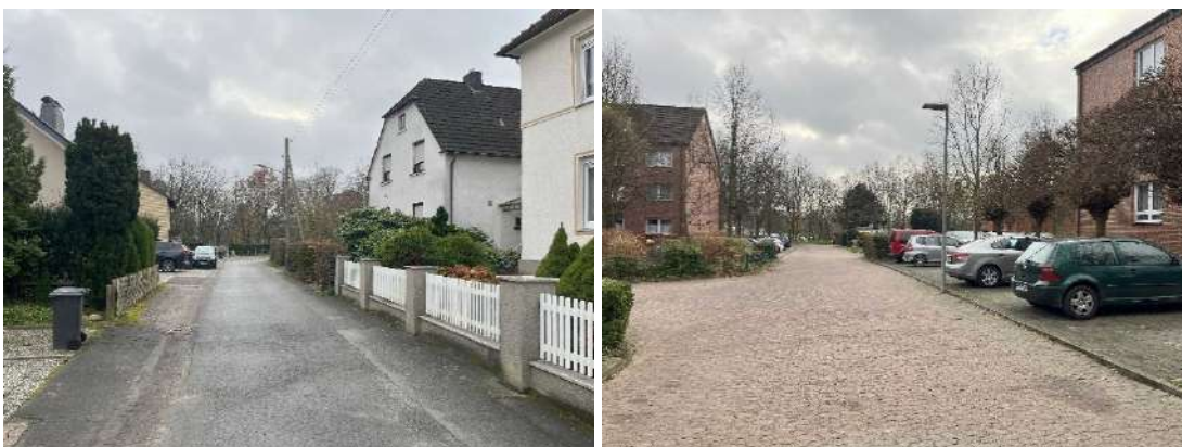
Abbildung 15: Fehlende Gehwege in der Scheffelstraße (links) und in der Welfenstraße (rechts)
