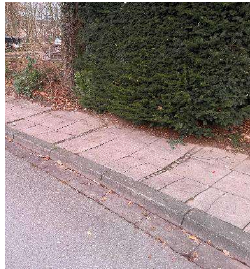
Abbildung 90: unebene Gehwegplatten im Banater Weg
