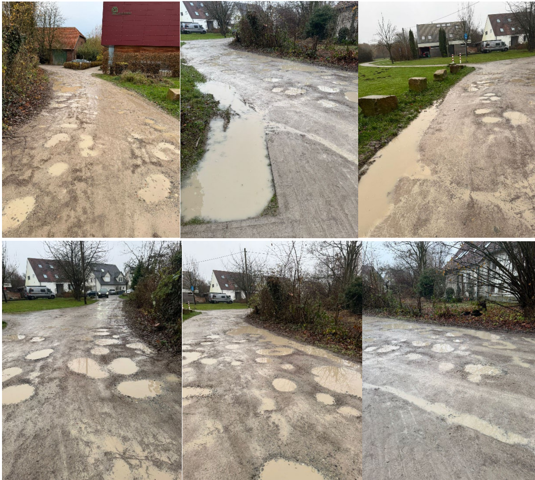
Zuwegung vor den letzten Arbeiten bei Regen (28.11.2025):
