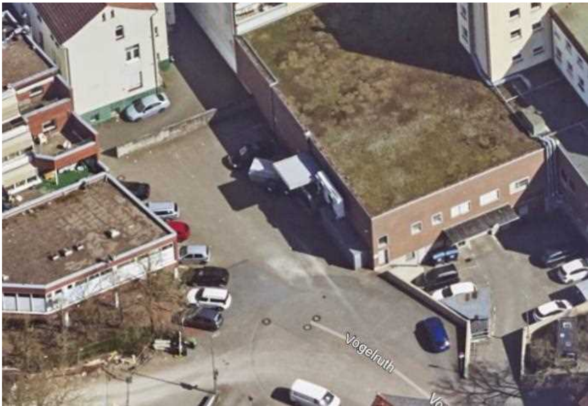
Abb. 2: Parkplatzfläche-Vogelruth mit Durchgang zur Hauptstr.
