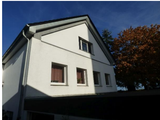
Abb. 29 Giebel an der Südostseite des Gebäudes.
