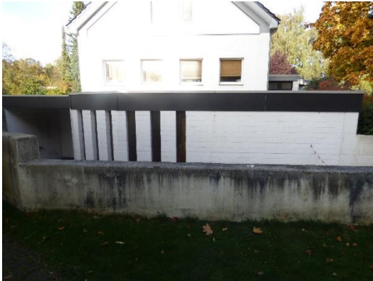
Abb. 30 Wandverkleidung an der Südostseite des Gebäudes.
