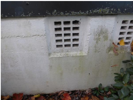
Abb. 32 Lüftungslöcher am südöstlichen Gebäudeteil.
