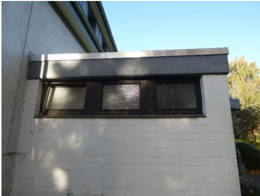
Abb. 24 Attikaverkleidung an der Nordostseite des Gebäudes.
