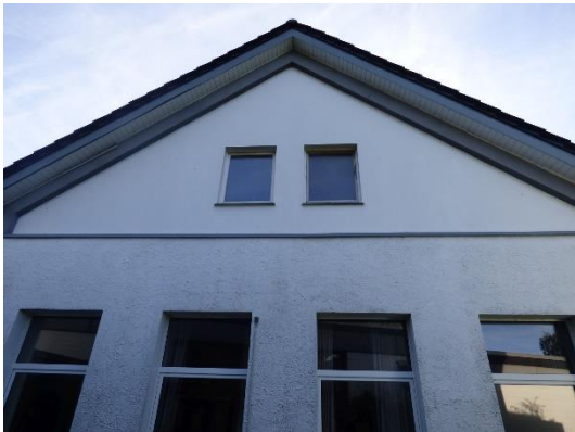
Abb. 28 Giebel an der Nordwestseite des Gebäudes.
