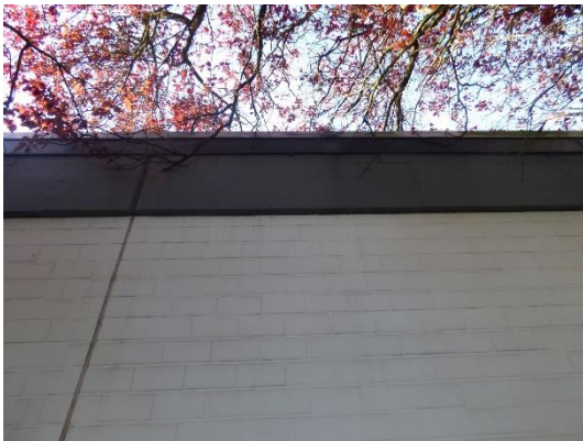
Abb. 26 Attikaverkleidung an der Nordostseite des Gebäudes.
