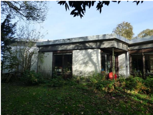
Abb. 37 Südansicht von Gebäude 2.
