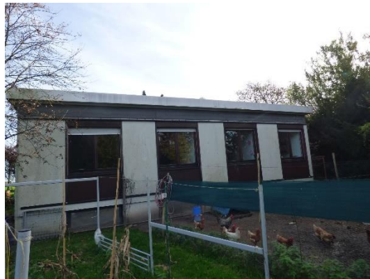
Abb. 36 Südwestansicht von Gebäude 2.
