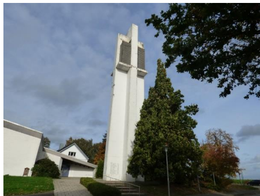
Abb. 6 Kirchturm im Plangebiet.
