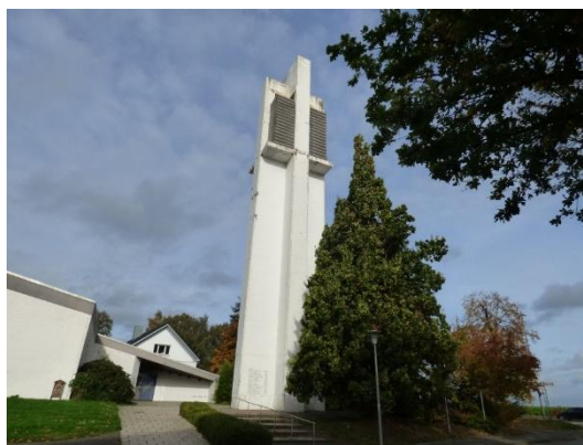
Abb. 5 Kirchturm im Plangebiet.
