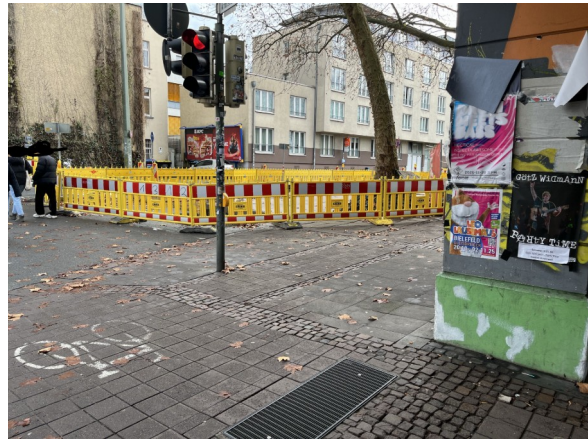
rechtwinklig abknickender Radweg, über Fußweg hinweg
