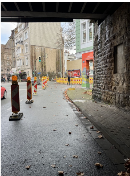
Absperrung der rechten Fahrspur am 30.11.2025
