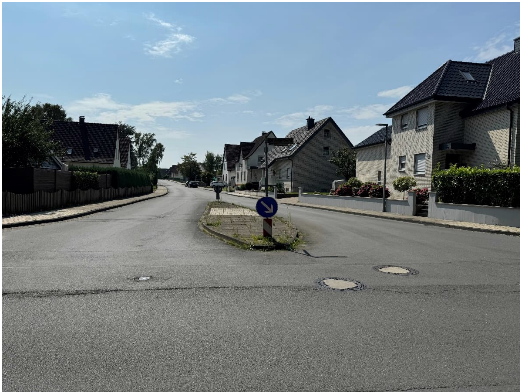
Abbildung 8 Einmündung Bentruperheider Weg / Salzufler Straße, Blickrichtung Süden
