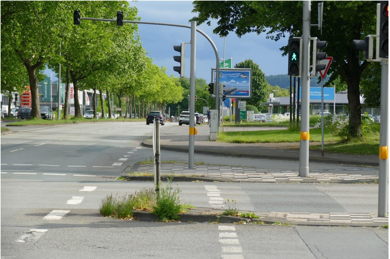
Kreuzung Jöllennecker - / Babenhauser Straße (keine Absenkung der Bordsteine)
