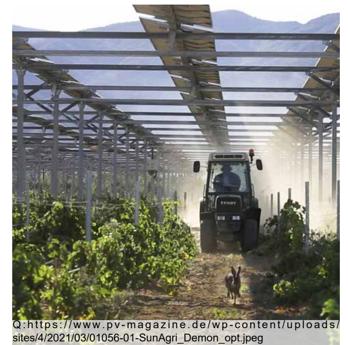
Abbildung 89: Beispiel einer hochaufgeständerten Agri-PV-Anlage
