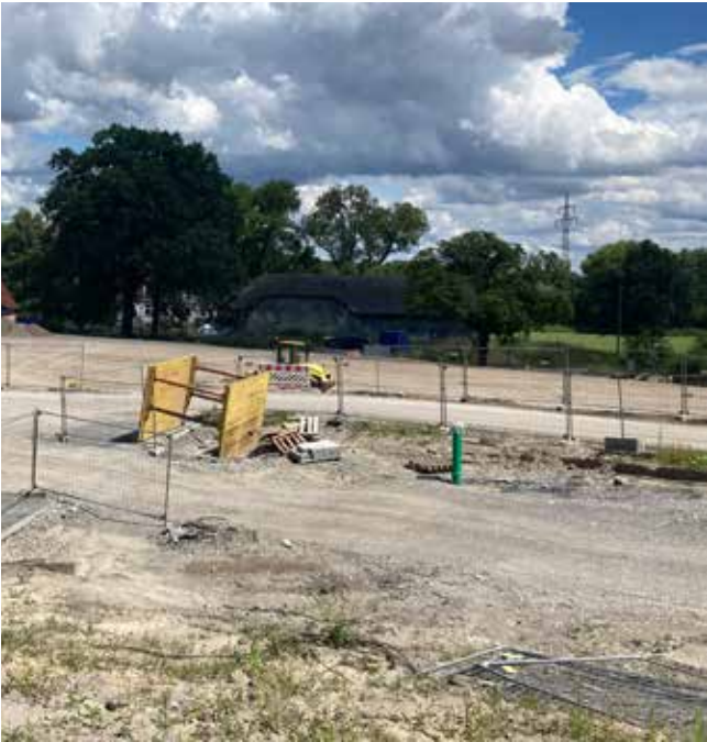
Abbildung 4: Laufende Vorbereitung der Baumaßnahme
