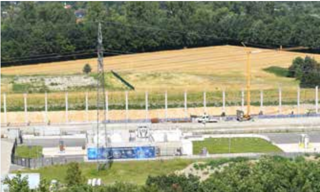
Abbildung 8: Laufende Bauarbeiten Busbetriebshof (Juli 2024)
