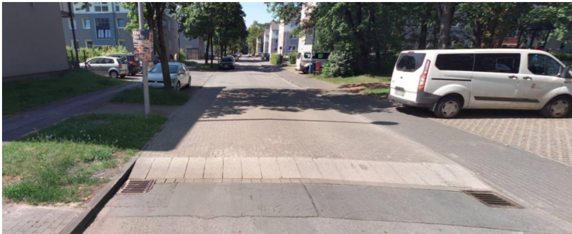
Abbildung 4: Bleicherfeldstraße, fahrdynamische Teilaufpflasterung (Bezirk Sennestadt)
