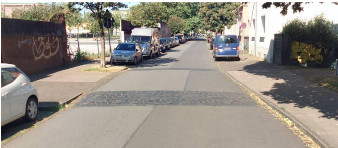
Abbildung 5: Webereistraße, optische Teilaufpflasterung (Bezirk Mitte)
