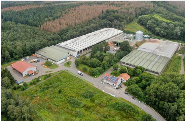
Abbildung 8: Recyclinghof Maibolte mit Kompostwerk in Lemgo
