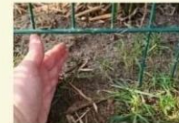
untere Streben ca. 10-15cm entfernen oder Zaun ab Höhe von 10 cm setzen
