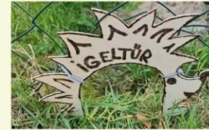
Igeltüren in Stabmattenzaun und Maschendrahtzaun mit 12x12cm Durchgang
