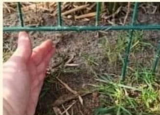
untere Streben ca. 10-15cm entfernen oder Zaun ab Höhe von 10 cm setzen
