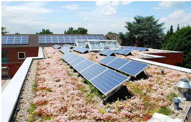
Dachbegrünung mit Photovoltaikmodulen (Quelle: www.optigruen.de/referenzen/solargruendach/erich-kaestner-schule-langenfeld/ )
