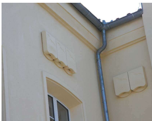
Fledermausaufsatzsteine an einer sanierten Fassade (Quelle: Amt für Stadtgrün, Naturschutz und Landschaftspflege, Rostock)
