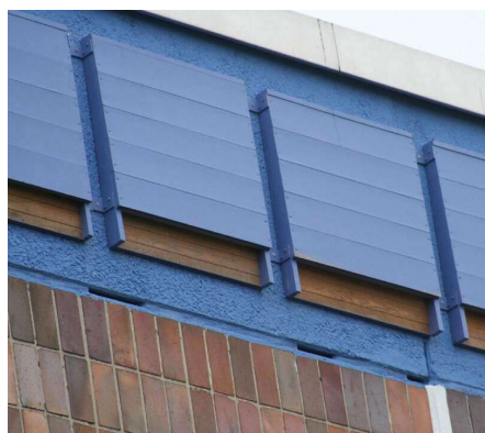
Kombination aus Fledermausspaltenquartieren (Schlitze an der Klinkeroberkante) und Spaltenkästen (Quelle: Amt für Stadtgrün, Naturschutz und Landschaftspflege, Rostock)
