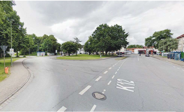
Bereich der Bushaltestellen (Blick aus nördlicher Richtung, links mögl. Zufahrt zum P+R)
