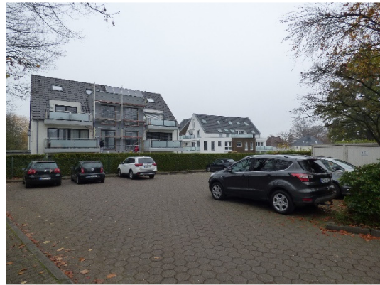
Abb. 4 Wohngebäude östlich des Plangebietes.
