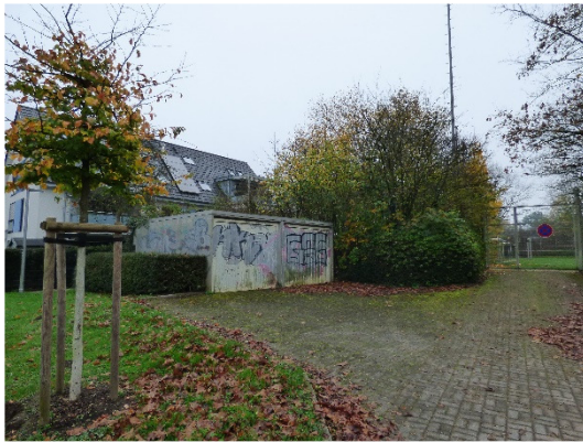
Abb. 3 Garage im Nordosten des Plangebietes.
