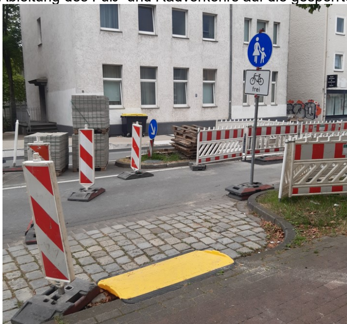
Ableitung des Fuß- und Radverkehrs auf die gesperrte Fahrbahn an einer Bordsteinabsenkung:
