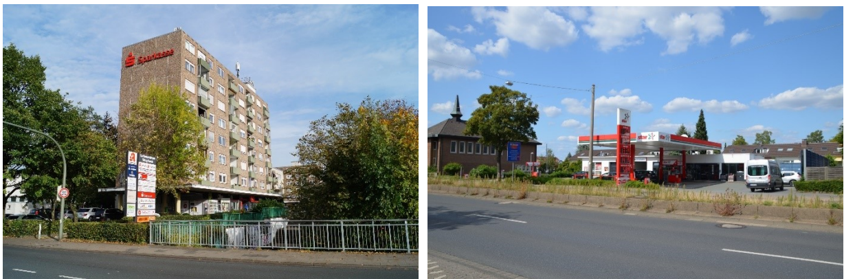
Abbildung 30: Zentrum Stieghorst / Nutzungen entlang Detmolder Straße
