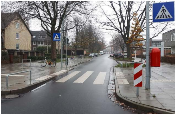
Abb. 41 Beispiele für Aufpflasterungen und vorgezogene Seitenräume
