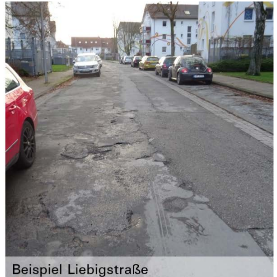
Abb. 34 Beispiel von schadhafte Fahrbahnoberflächen
