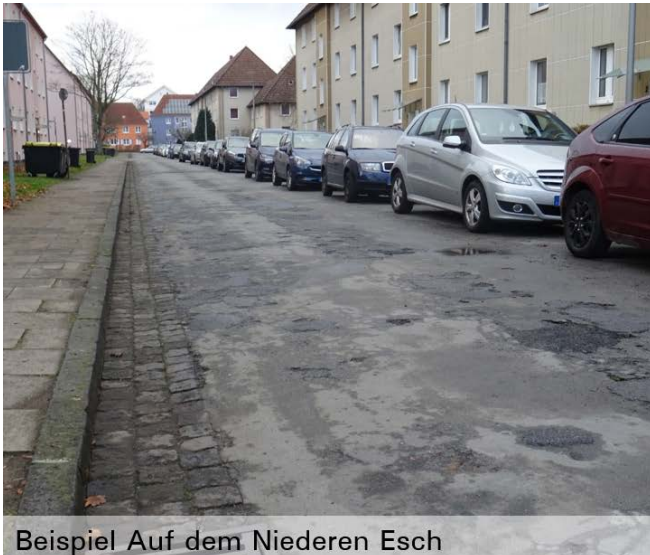
Abb. 34 Beispiel von schadhafte Fahrbahnoberflächen
