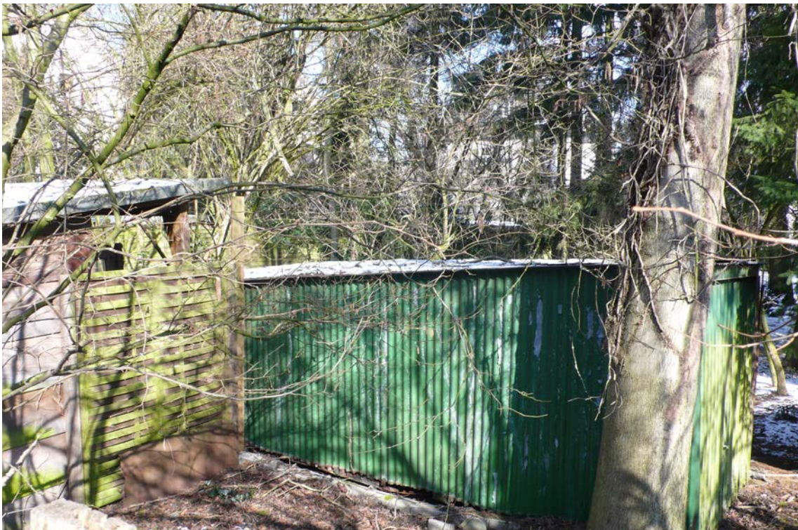
Gartenhaus und alte Garage innerhalb einer nicht überbaubaren Fläche östlich der Mittelstraße
