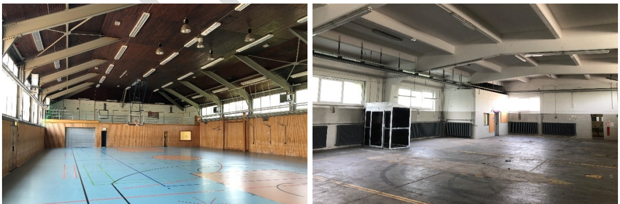
Abbildung 50: Gebäudeausstattung Sporthalle / Lagerhalle
