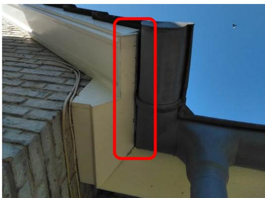
**Abb. 4** Blick auf die Spalte zwischen Dachüberstandsverkleidung und Dacheindeckung.
