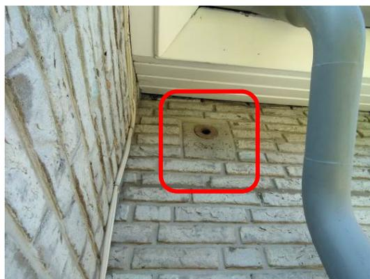
**Abb. 5** Beispiel eines fassadenintegrierten Niststeins.
