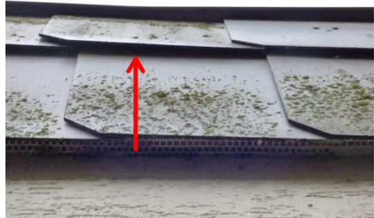
**Abb. 29 Spalten hinter Schindeln an der nordwestlichen Fassade des niedrigen Gebäudeteils.**
