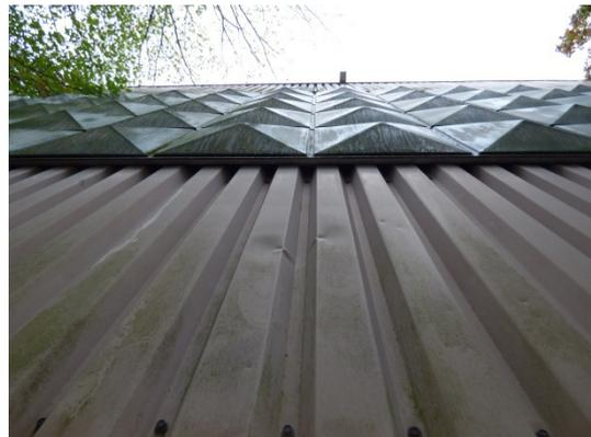
**Abb. 27 Zwischenraum hinter den Platten auf dem Wellblech.**
