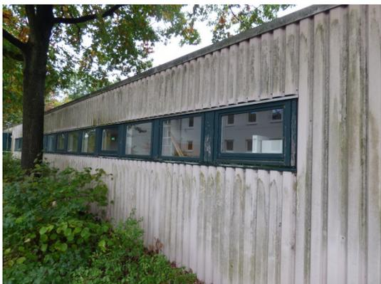
Abb. 23 Wellblech an der nordöstlichen Fassade des niedrigen Gebäudeteils.
