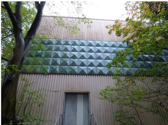
**Abb. 26 Platten auf dem Wellblech an der südöstlichen Fassade des Gebäudes.**
