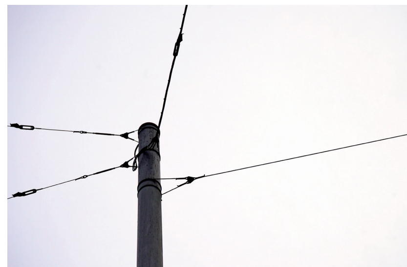
Jahnplatz Bestand - Überspannungsmast. Foto: EHL
