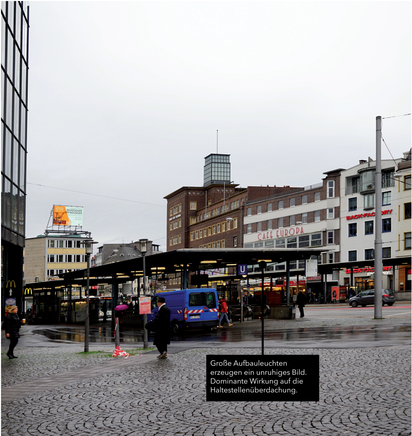
Jahnplatz Bestand - Haltestellenüberdachung. Foto: EHL
