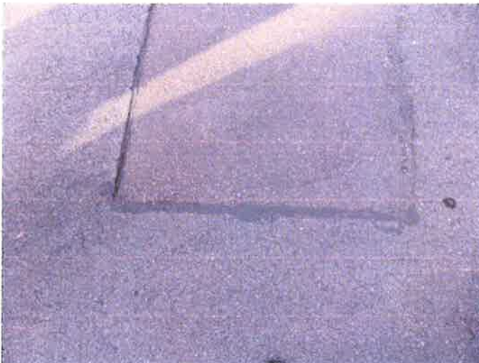
Abbildung 6 eine fachgerechte Reparaturstelle
