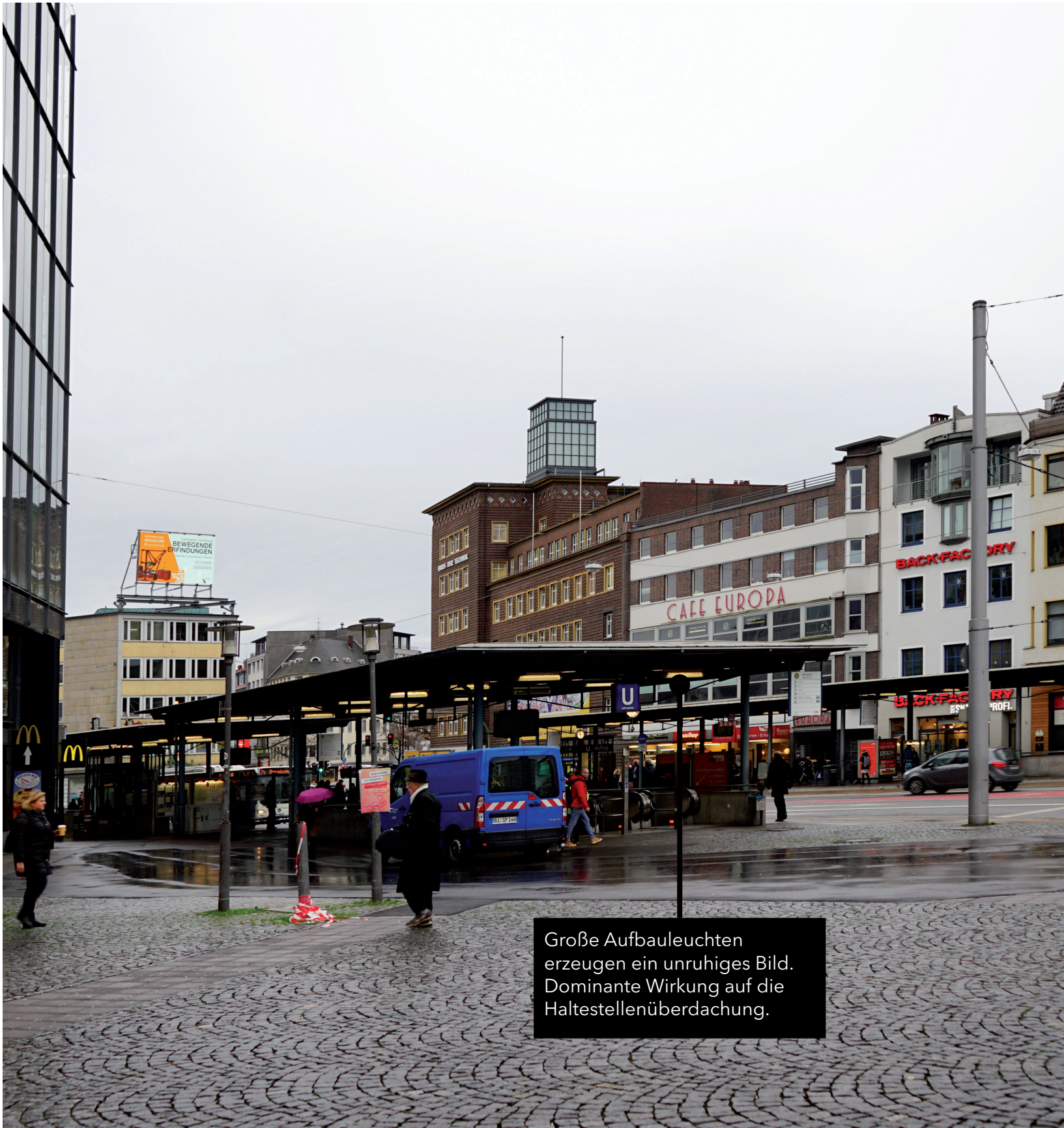
Jahnplatz Bestand - Haltestellenüberdachung. Foto: EHL
