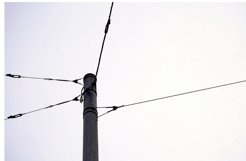
Jahnplatz Bestand - Überspannungsmast. Foto: EHL
