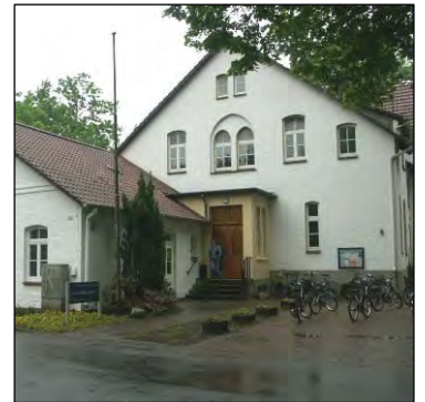
Erhaltenswerte Bausubstanz: Gemeindehaus „Kuhlo“
