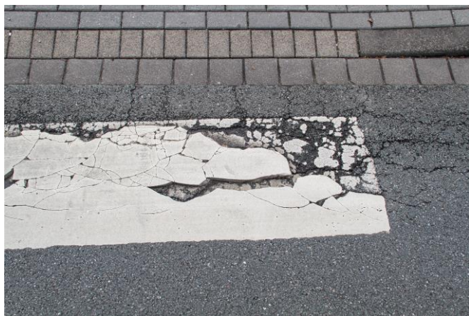
Fußgängerüberweg Senner Straße auf Höhe des Begegnungszentrums Neue Schanze.
