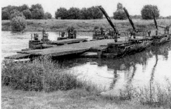
Brückenschlag: In Minden üben die Pioniere der Bundeswehr den Bau von Brücken über die Weser.
