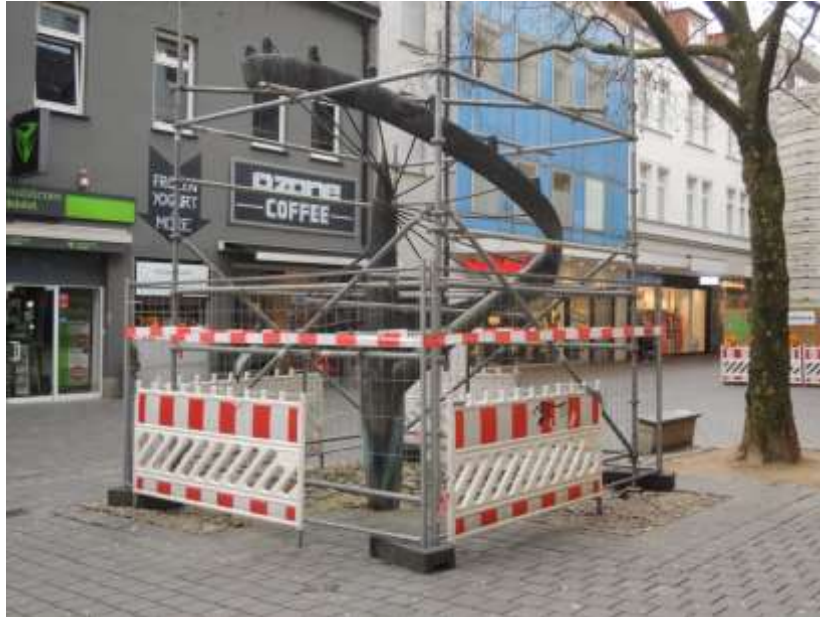
Spindelbrunnen 04.02.2018 (abgesperrt und stabilisiert)
