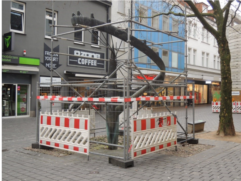
Spindelbrunnen 04.02.2018 (abgesperrt und stabilisiert)
