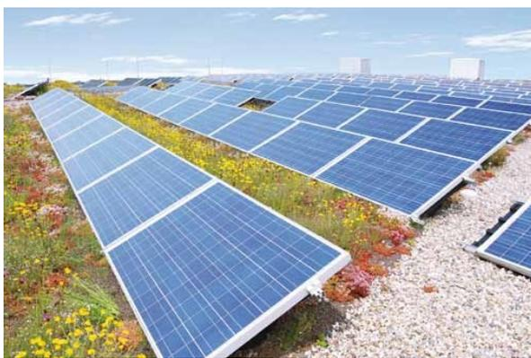
**Dachbegrünung mit Photovoltaikmodulen**
