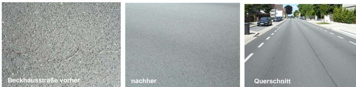
**Abb. 17: Lärmarme Fahrbahnbeläge**
