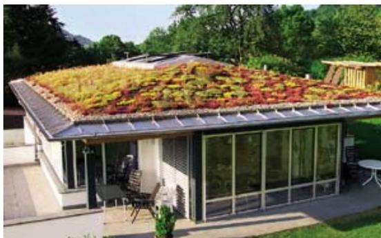
**Extensive Flach- und Schrägdachbegrünung (Quelle: [www.optigruen.de](http://www.optigruen.de))**
