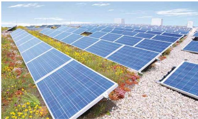
**Dachbegrünung mit Photovoltaikmodulen (Quelle: OPTIGRÜN 2010)**
