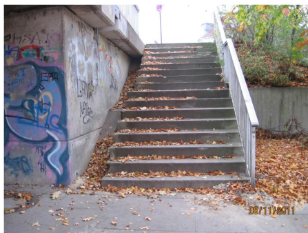
Treppe vom Parkplatz Bolbrinkersweg zum Haller Weg
