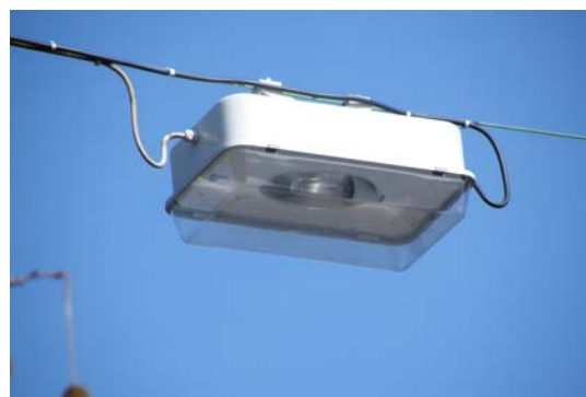
Trilux 8771 z. B. mit Natriumhochdruckdampf Lampe 100 W in Kreuzungsbereichen mit 150 W
