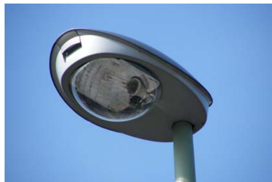
Siteco, SQ 100 z. B. mit Natriumhochdruckdampf Lampe 70 W
