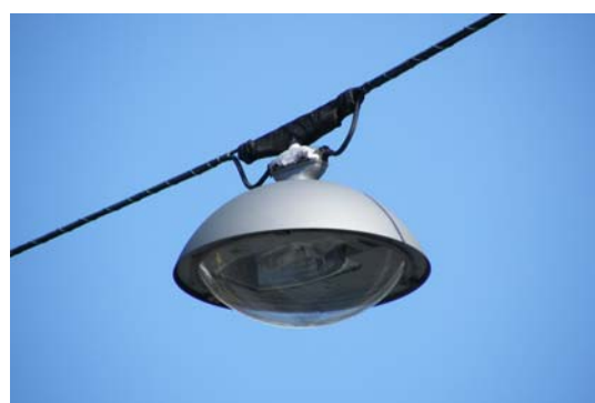
Siteco, DL 500 z. B. mit Natriumhochdruckdampf Lampe 100 W in Kreuzungsbereichen mit 150 W
