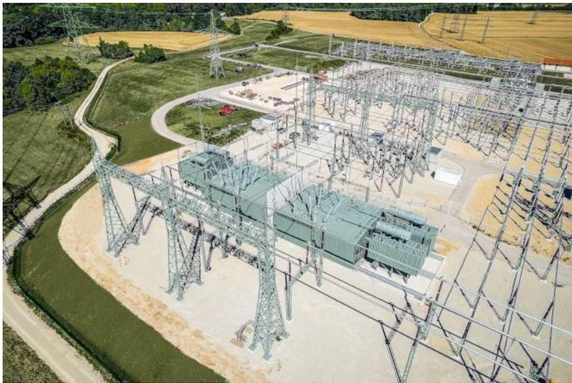
4 Phasenschieber im TenneT-Umspannwerk Würgau (2022)
