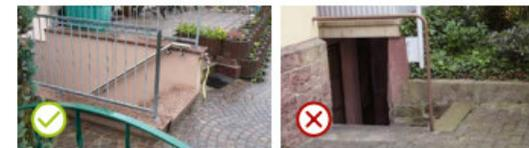
**Bei außenliegenden Kellertreppen** kann durch eine Schwelle und/oder eine Überdachung verhindert werden, dass Oberflächenwasser in die Kellerräume läuft.
