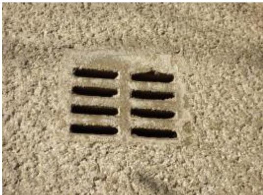
**Abb. 22 Lüftungspalten an der Ostseite des Toilettenhauses.**
