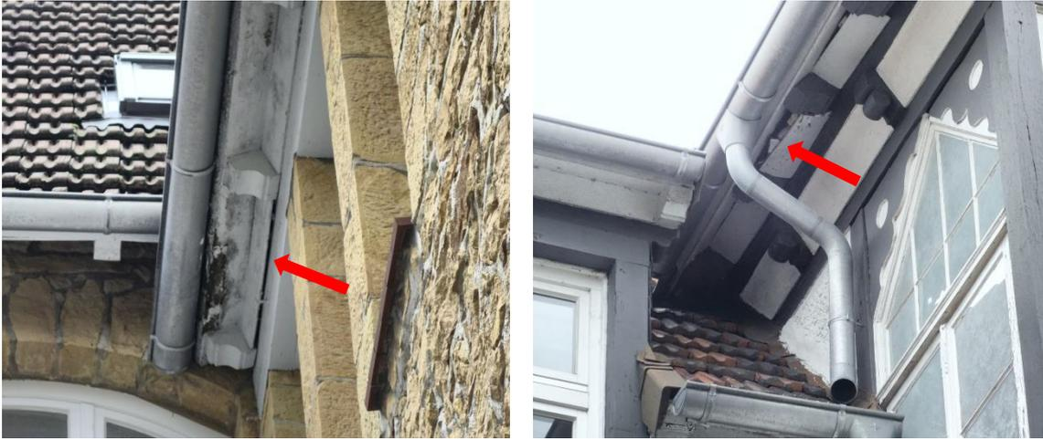
**Abb. 3-14: Spalten im Bereich der Dachtraufe als potenzielle Einflugmöglichkeiten**
