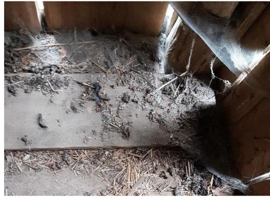
**Abb. 47 Marderkot auf dem Dachboden.**
