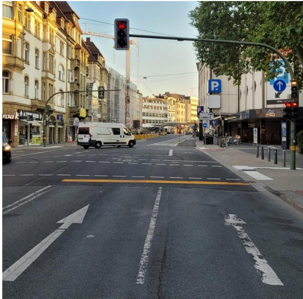
*Abb. 1: Blick auf die Kreuzung von der Herforder Straße in Richtung Jahnplatz – die rechte KFZ-Spur mündet auf dem Radweg, die linke auf der Busspur ohne zusätzliche Markierungen für eine Verschwenkung bzw. Einfädelung (denn aus zwei MiV-Spuren wird hier eine MiV-Spur)*
