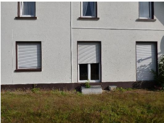
**Abb. 31** Rollladenkästen mit Spalten an der Südseite von Gebäude 1.
