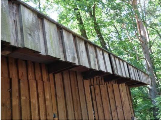
Abb. 32 Spalten an der Dachverkleidung.
