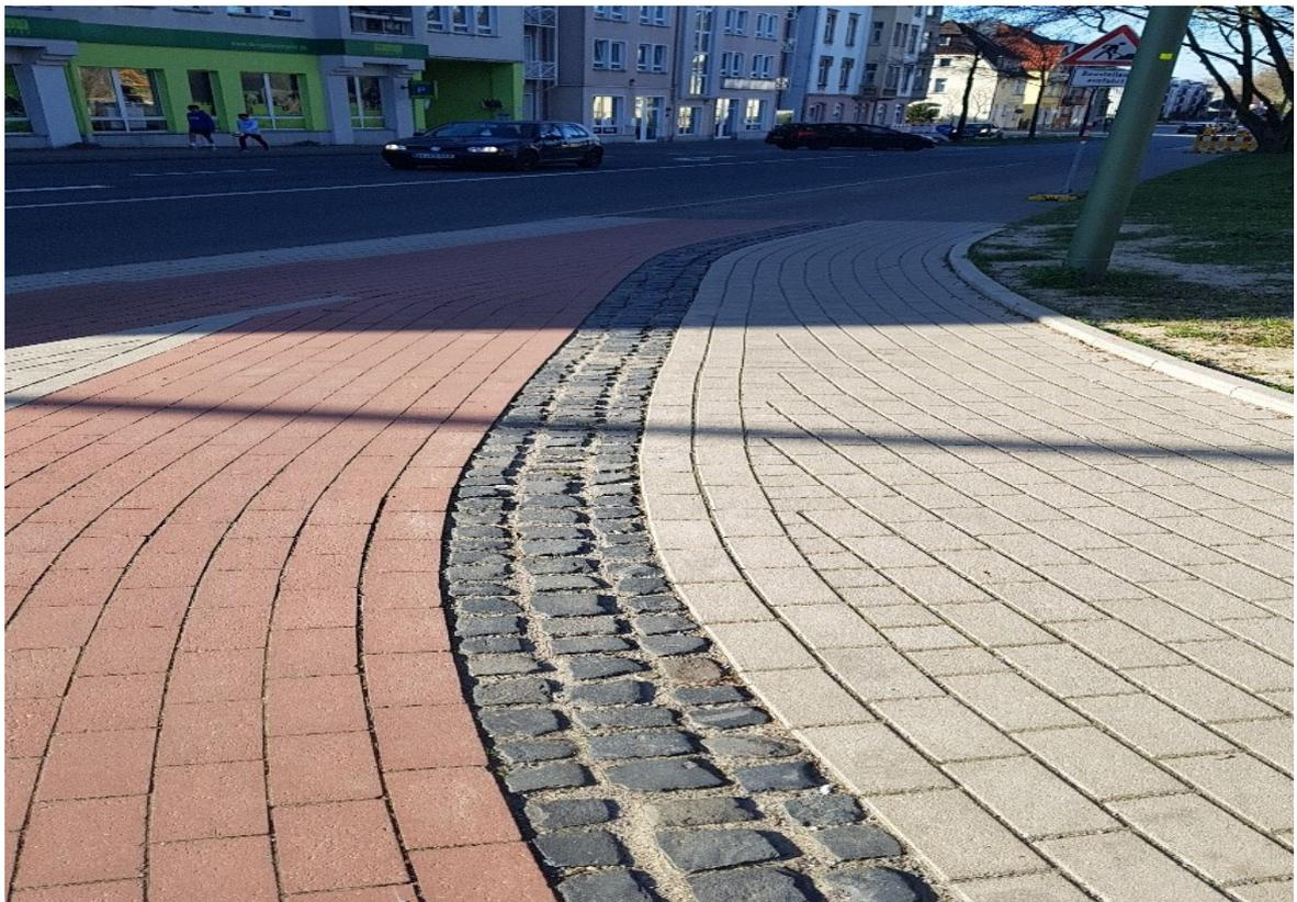
Beispiel: Taktile Trennstreifen aus Basaltpflaster zwischen Radweg und Gehweg
